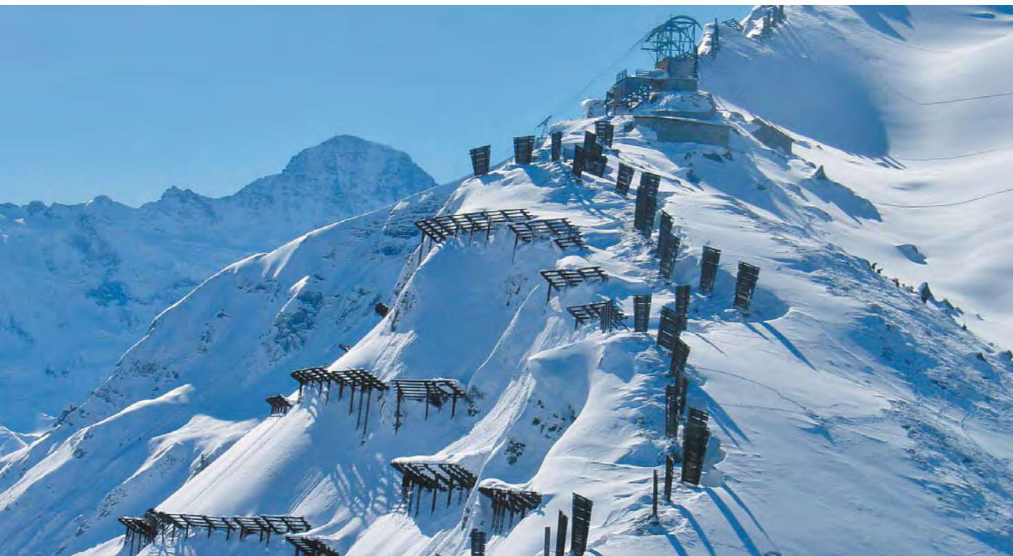
Lawinenverbauungen an der Marchegg: Schutzbauten sind ein wichtiges Element im integralen Schutz vor Naturgefahren.
